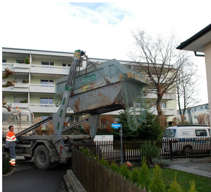
Sanierung Baulos III
