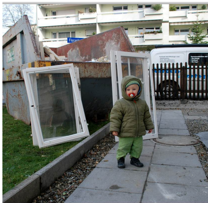
Sanierung Baulos III
