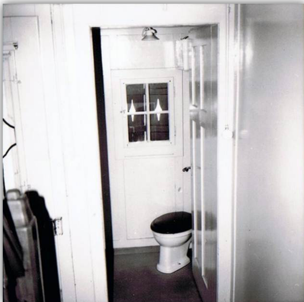
WC im Baulos I, ca. 1976
